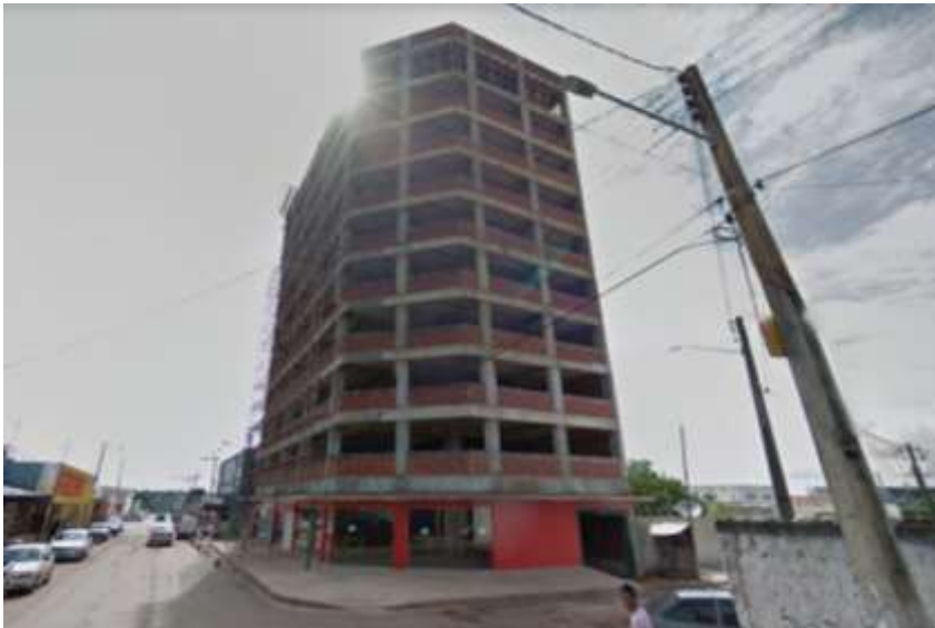
Edifício Empresarial em Construção
