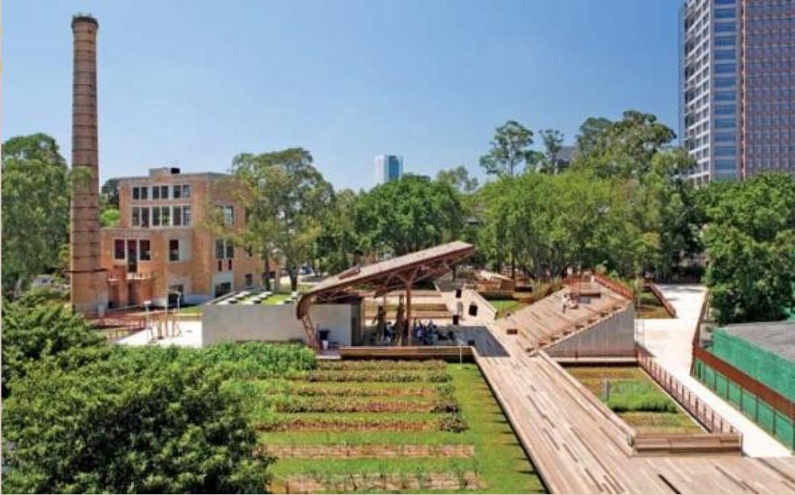
Figura 3 - Arena coberta e arquibancada. Fonte: Levisky Arquitetos
